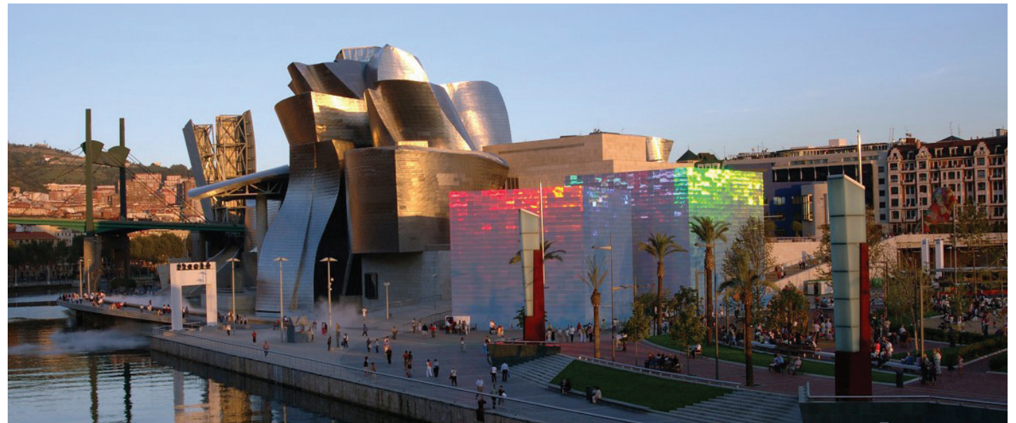
Guggenheim Museum, Bilbao / Guggenheim Museum, Bilbao
