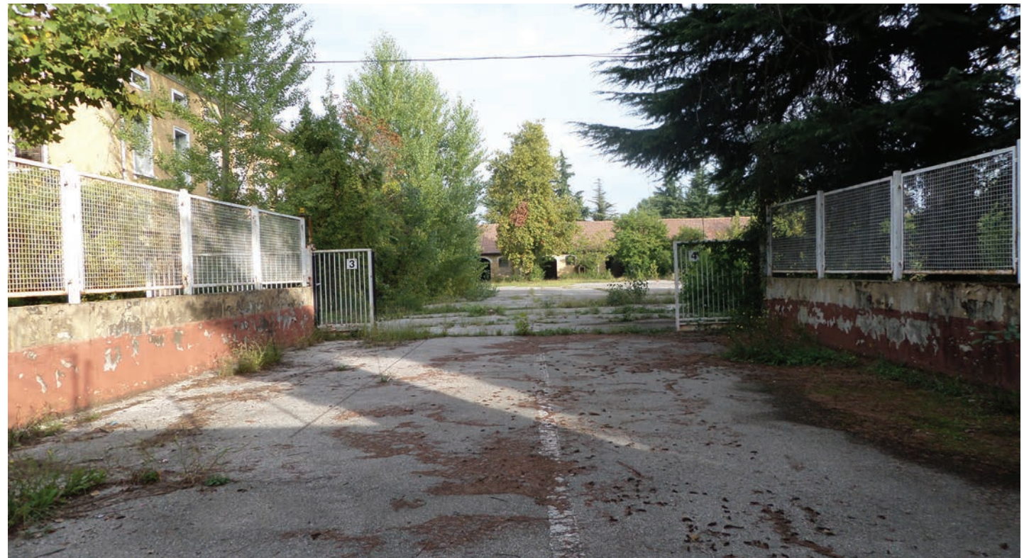
Fig.3: ex Caserma Tommaso Salsa, Treviso. Fotografia di Federico Camerin (2015) / Imm.3: former Tommaso Salsa barrack, (Treviso, Italy). Photographer Federico Camerin (2015)
