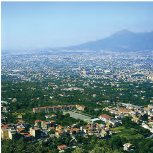
Insedimenti nella pianura del Sarno: veduta da est / Sarno plain settlements: eastern view
