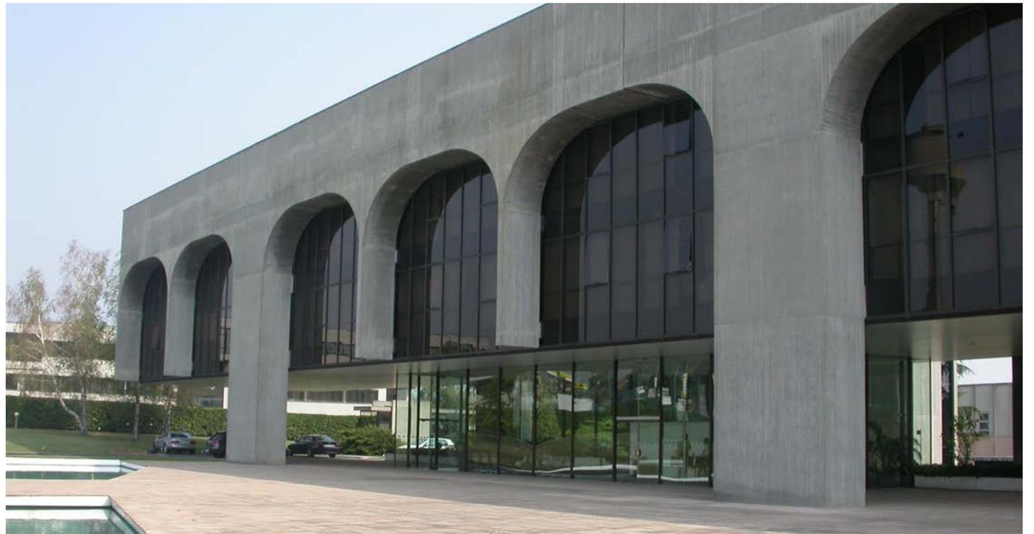
questo artificio costruttivo consente di avere i piani degli uffici totalmente sgombri da pilastri e dunque organizzabili in piena libertà e permette di troncare a mezz'aria alcuni pilastri, che funzionano come tiranti, imprimendo sorpresa e levità all'immagine dell'edificio.
