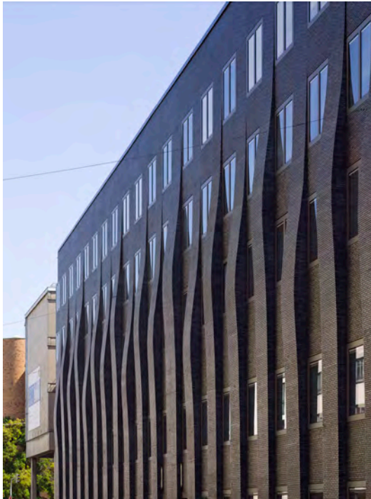
Hild und K, Recupero dell'edificio della Technische Universität di Monaco con la nuova facciata, 2007-2012
