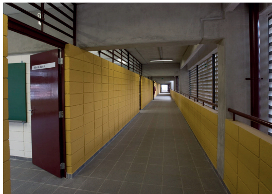
Sopra / Above FMGF, escola a Varzea Paulista, il rapporto tra gli spazi serviti, la struttura e la gelosia modulare e dettaglio della texture della facciata / FMGF, escola a Varzea Paulista, relationship between served spaces, structure and modular sunsreen and detail of facade texture
