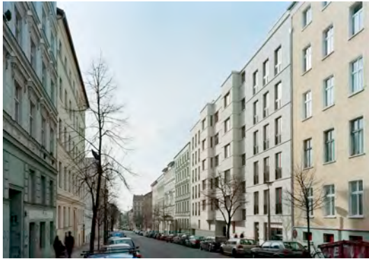
Modersohn & Freiesleben, edificio residenziale sulla Choriner Straße, Berlino, 2005-2008
